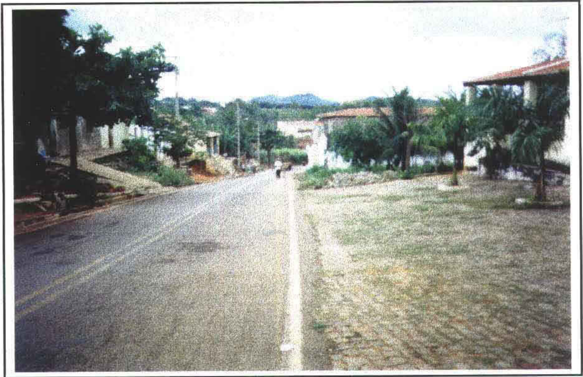
FOTO 04/23 - TIRADA NO CAMINHAMENTO ENTRE AS ESTACAS 218 À 215
