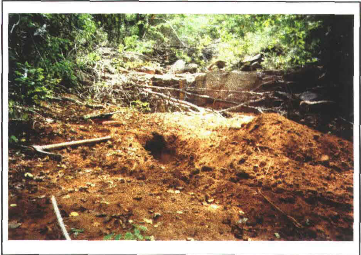
FOTO 23/23 – TIRADA NO INICIO DA ADUTORA - FURO 01
