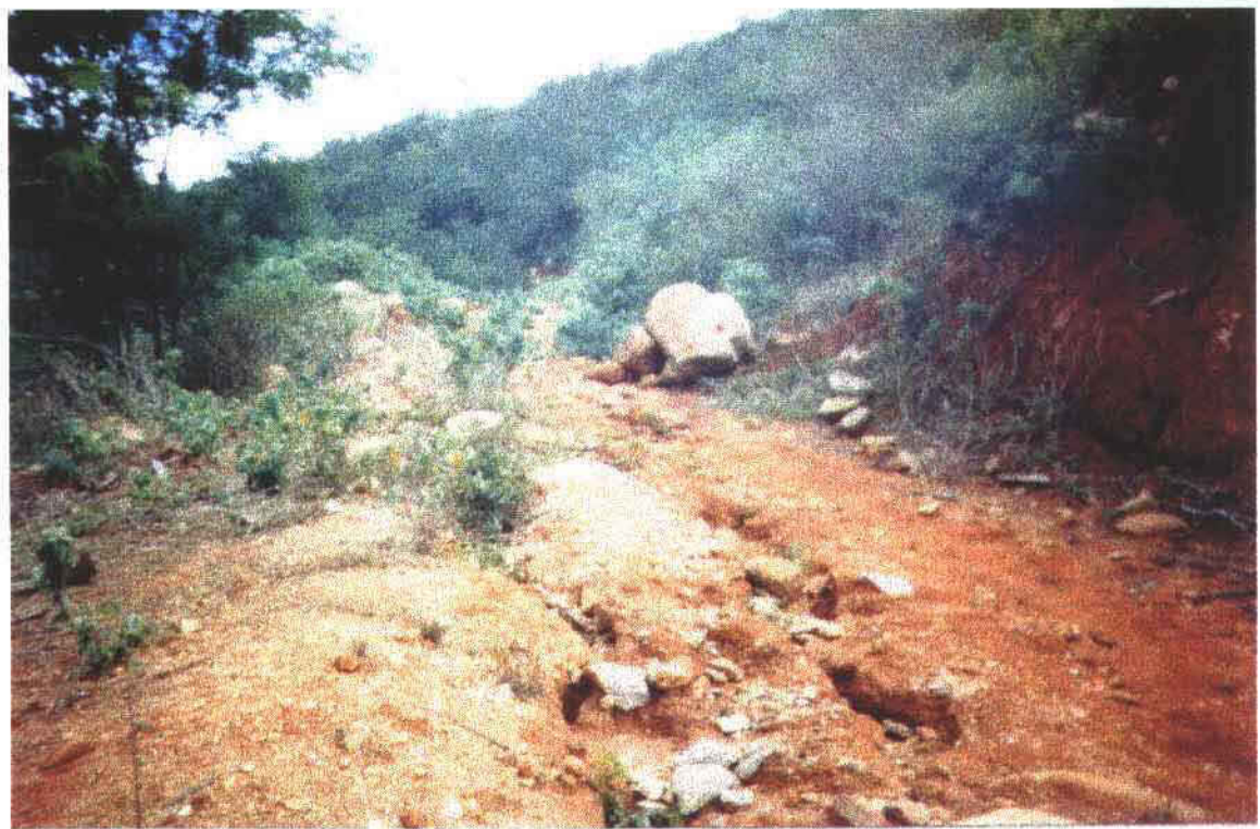
FOTO 16/23 – TIRADA ENTRE AS ESTACAS 68 À 60 - ROCHA EXPOSTA
