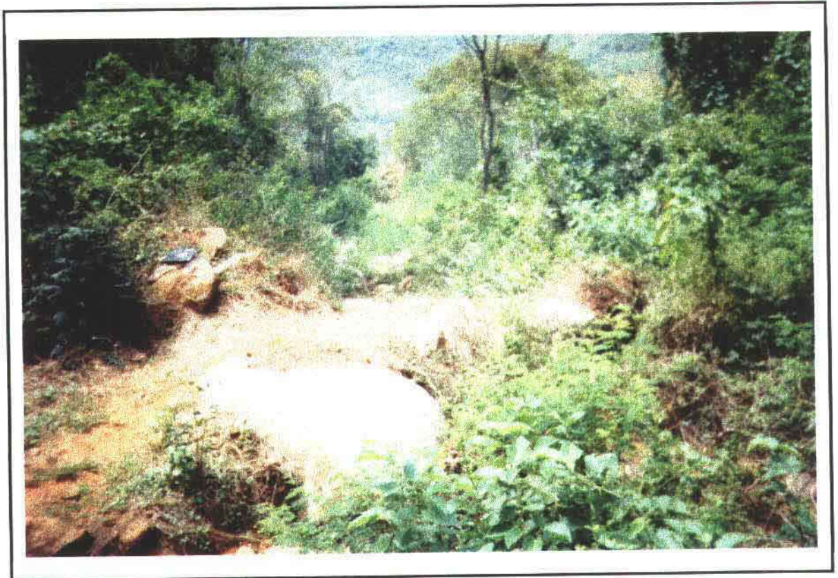
FOTO 17/23 – TIRADA ENTRE AS ESTACAS 68 À 60 - ROCHA EXPOSTA
