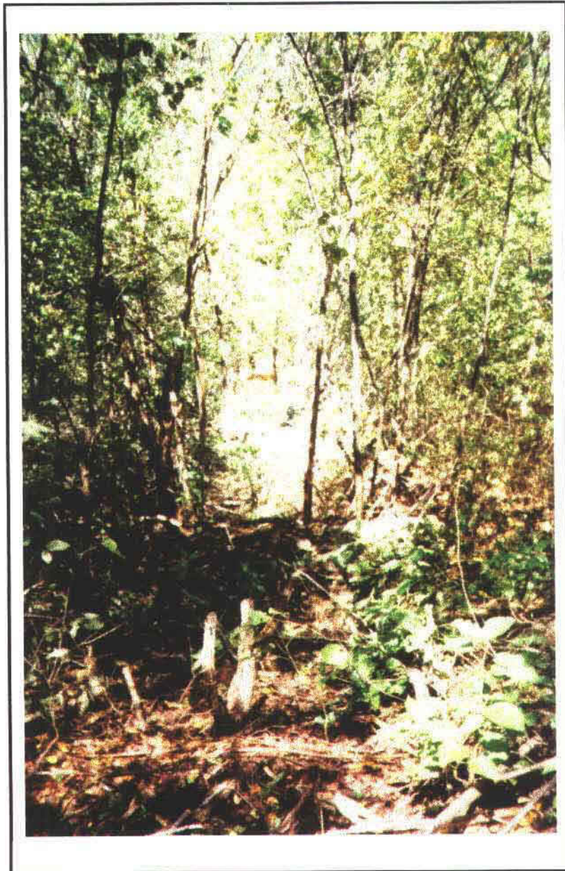
FOTOS 21/23 –TIRADA ENTRE AS ESTACAS 09 À 05 - ROCHA
