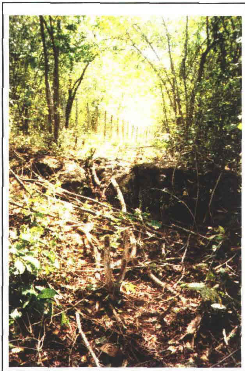
FOTOS 22/23 –TIRADA ENTRE AS ESTACAS 09 À 05 - ROCHA
